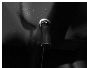
Boia do tanque de recuperação
